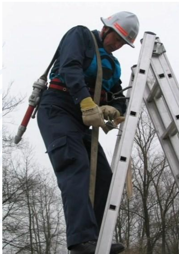
PRIPENJANJE PRITRDILCA NA LESTEV-NI DOLOČENO NA KATERI KLIN
